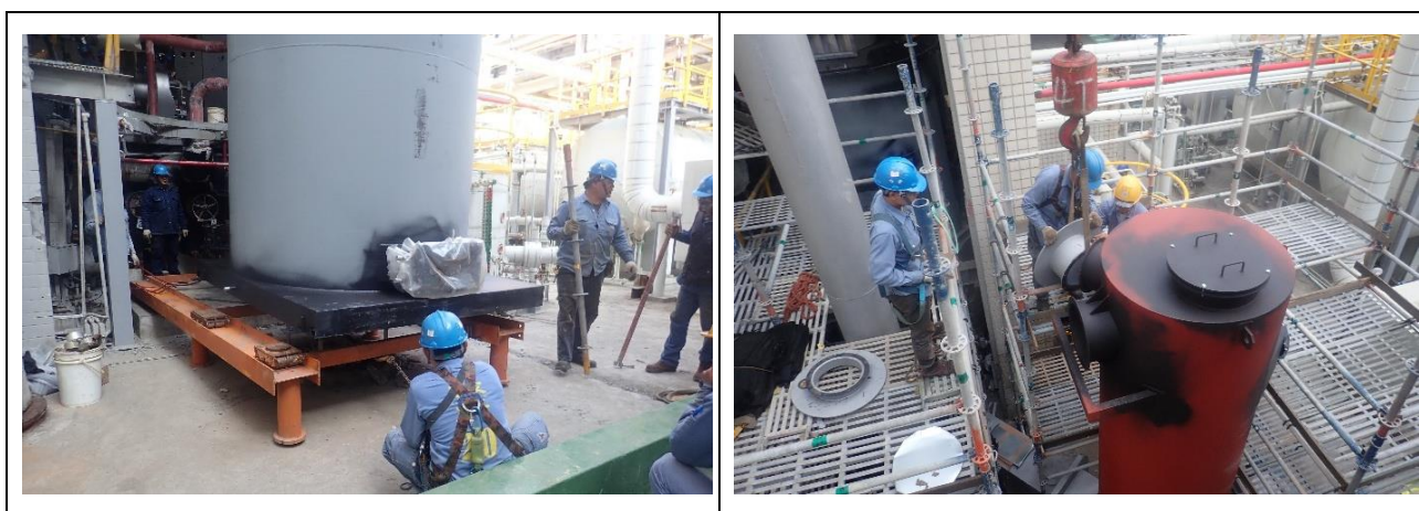
圖 9 燃油改燃氣之施工情形
