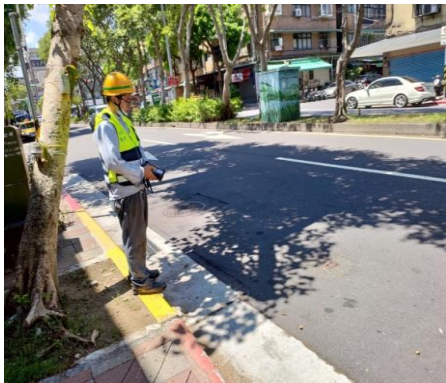
柏油路面中壓管線巡查
