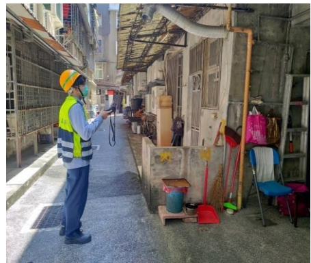
低壓管線巡查
