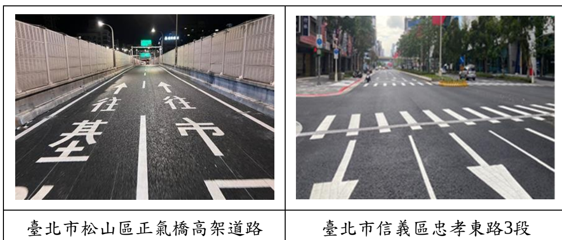
圖2、 道路維護改善使用再生瀝青混凝土成果
