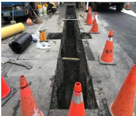
重慶南路3段67號管線汰換
