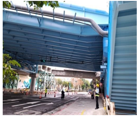
民權大橋高壓管線巡查
