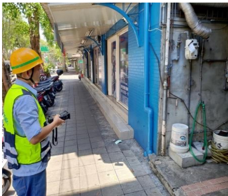
低壓管線巡查
