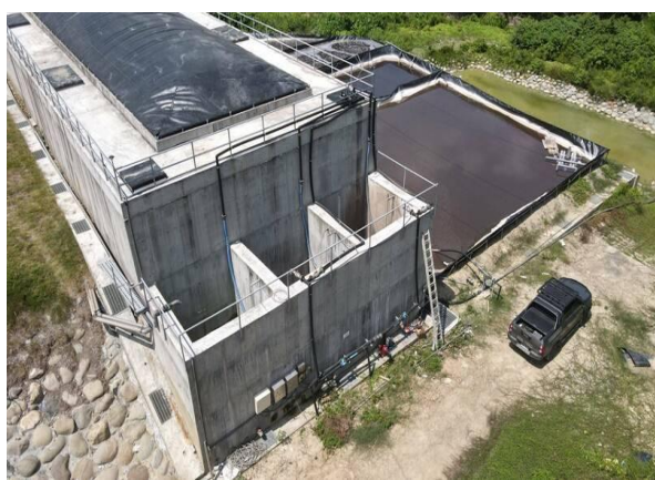
內門畜牧廢水資源化中心沼氣回收
