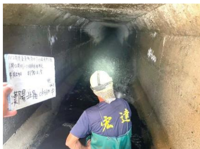
圖2-5 辦理雨水下水道清淤作業
