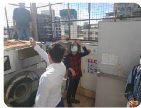
屋頂現況確認 (水塔、設備或違建)
