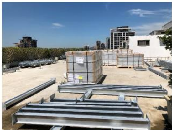
材料進場（吊掛）
