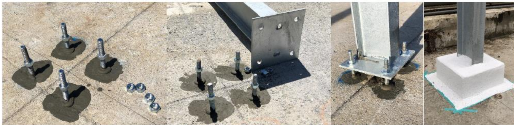
放樣、植筋、防水層施作與基座混凝土澆置
