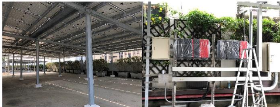
電氣設施安裝（模組接地/串接、安裝變流器、配線）、監控系統
