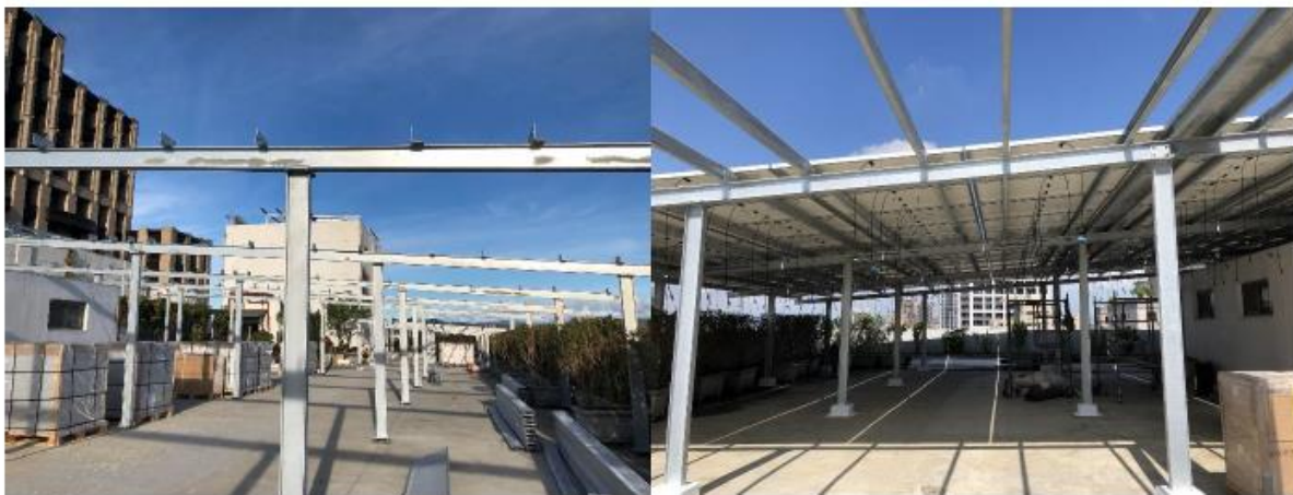
支架與模組安裝（水平/垂直度確認）
