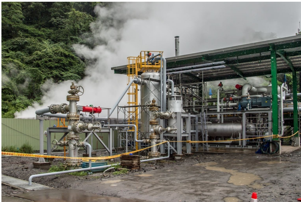
圖 3-3 仁澤地熱電廠朗肯雙循環發電機組
