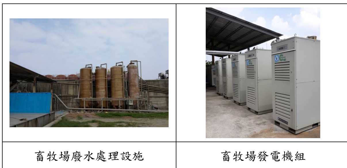
圖 2.1-5、畜牧廢棄再利用推動沼氣發電
