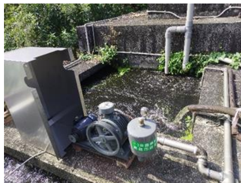
廢水處理曝氣機汰舊換新
