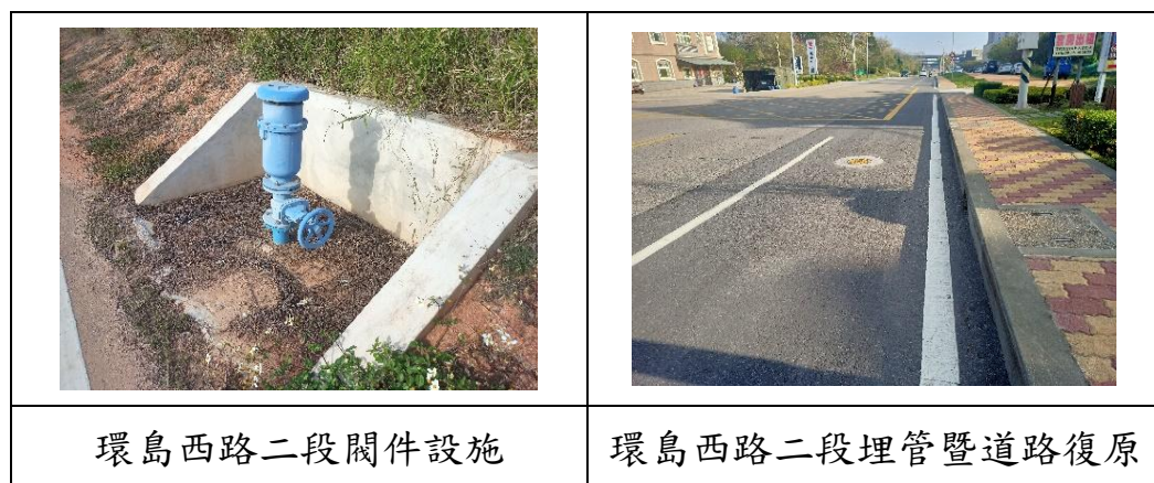
圖 1、瓊安路-環島西路二段-西浦頭水塔送水管新建工程 (第二標)
