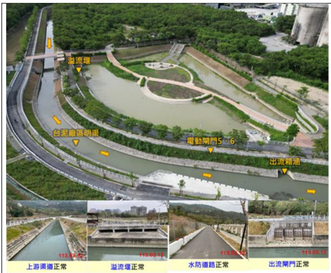
水利建造物檢查與修繕作業
