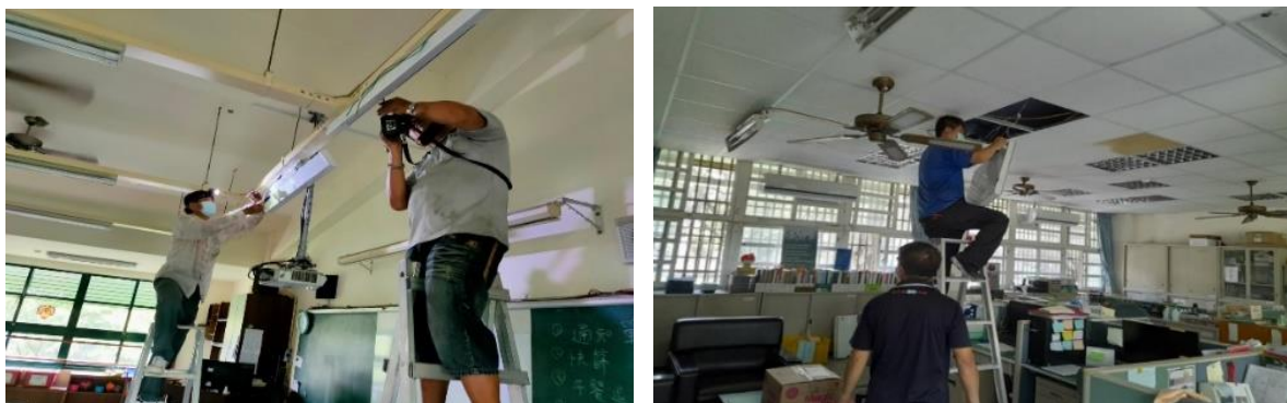
圖 16 汰換老舊設備
