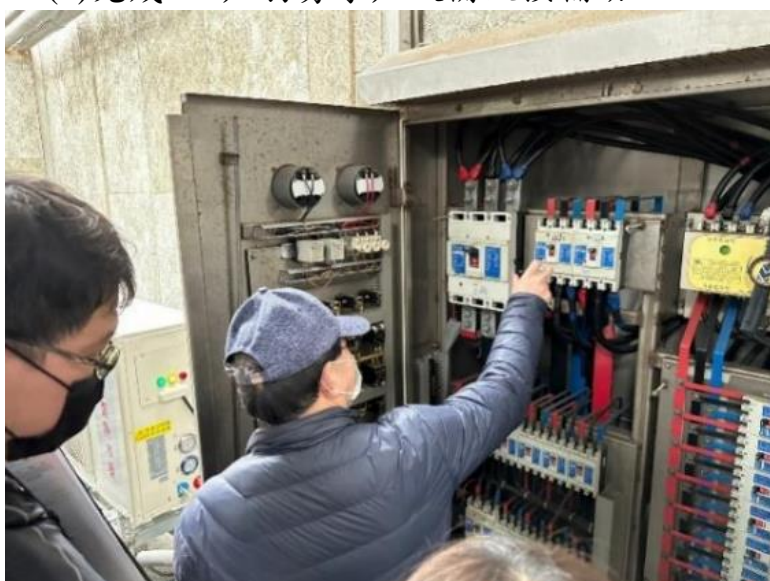
圖 2-5 本縣中大型用電大戶現場節能診斷輔導
