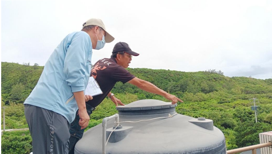
圖 2 離島蓄水池水塔及飲水設備體檢輔導
