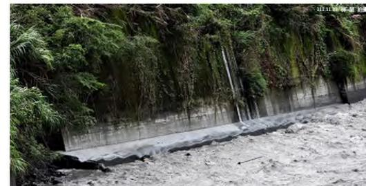
台7甲線9.4K區段，RC護岸工趾部混凝土，因受長期之溪洪挾帶卵礫石之撞擊磨耗而形成波浪狀之凹凸蝕刻痕跡
