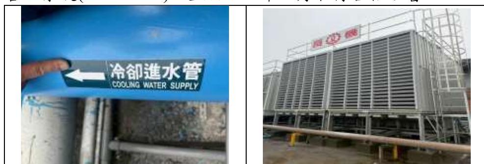
圖 2-4、金酒公司金寧廠釀酒二場空調 800RT 冷卻水塔及周邊管路汰換
