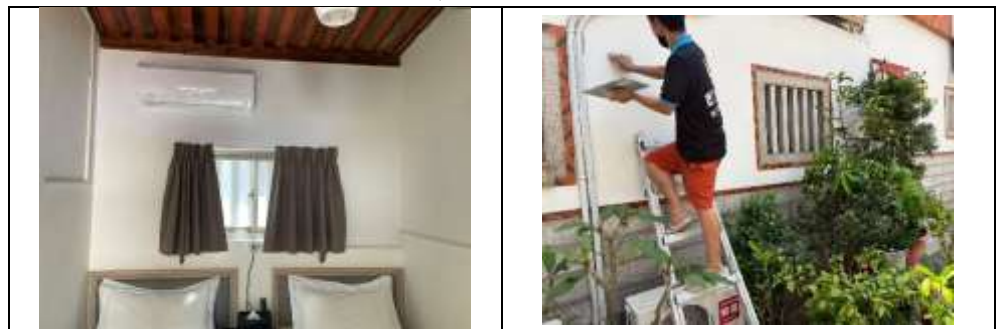
圖 2-6、旅宿業建築隔熱窗簾與隔熱膜施作
