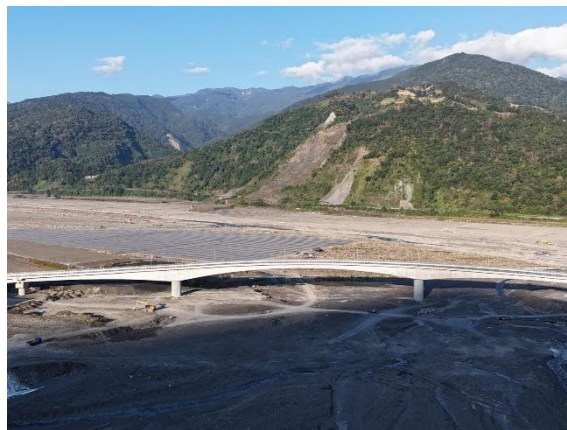
圖2-3 瑪崙橋改建完工照
