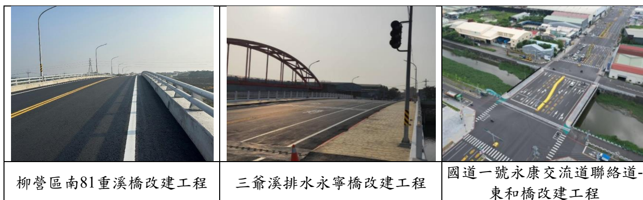
圖2.3 橋梁改建工程完工照片
