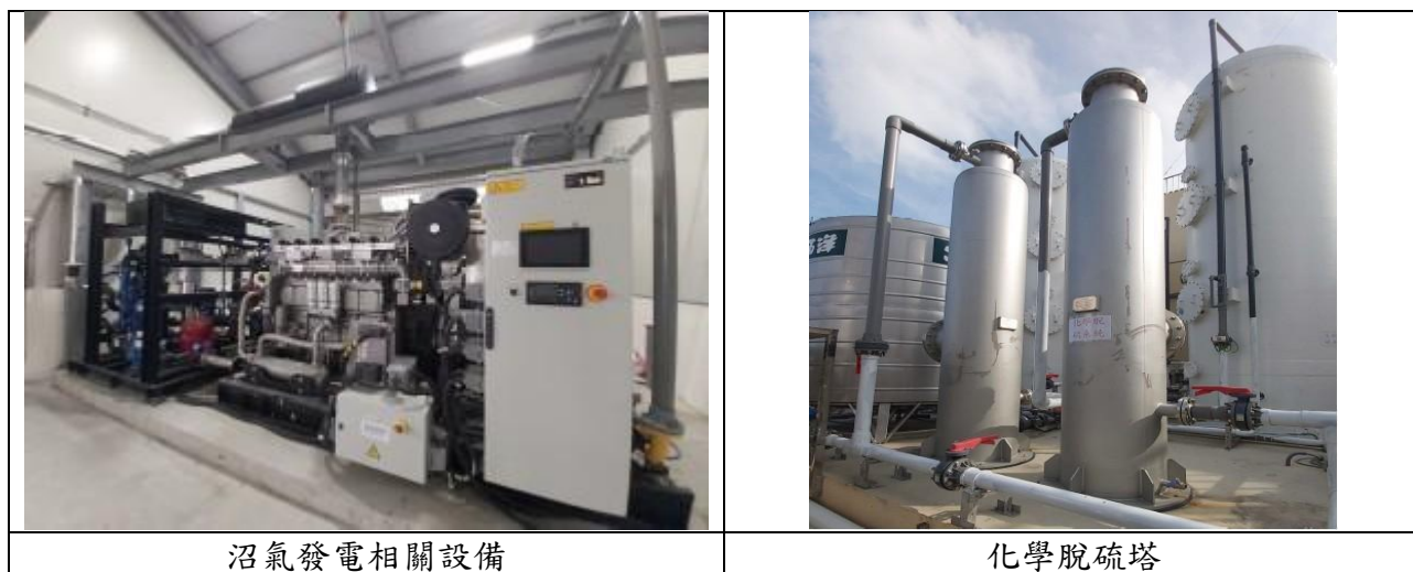
圖2.21 沼氣發電設備示意圖
