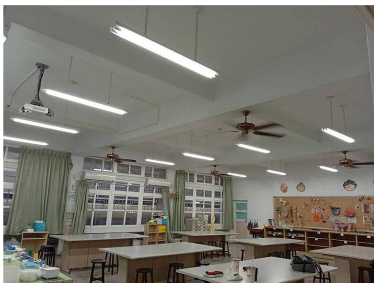
圖 9 全面汰換教室內老舊燈具，改裝高效率 LED 燈
