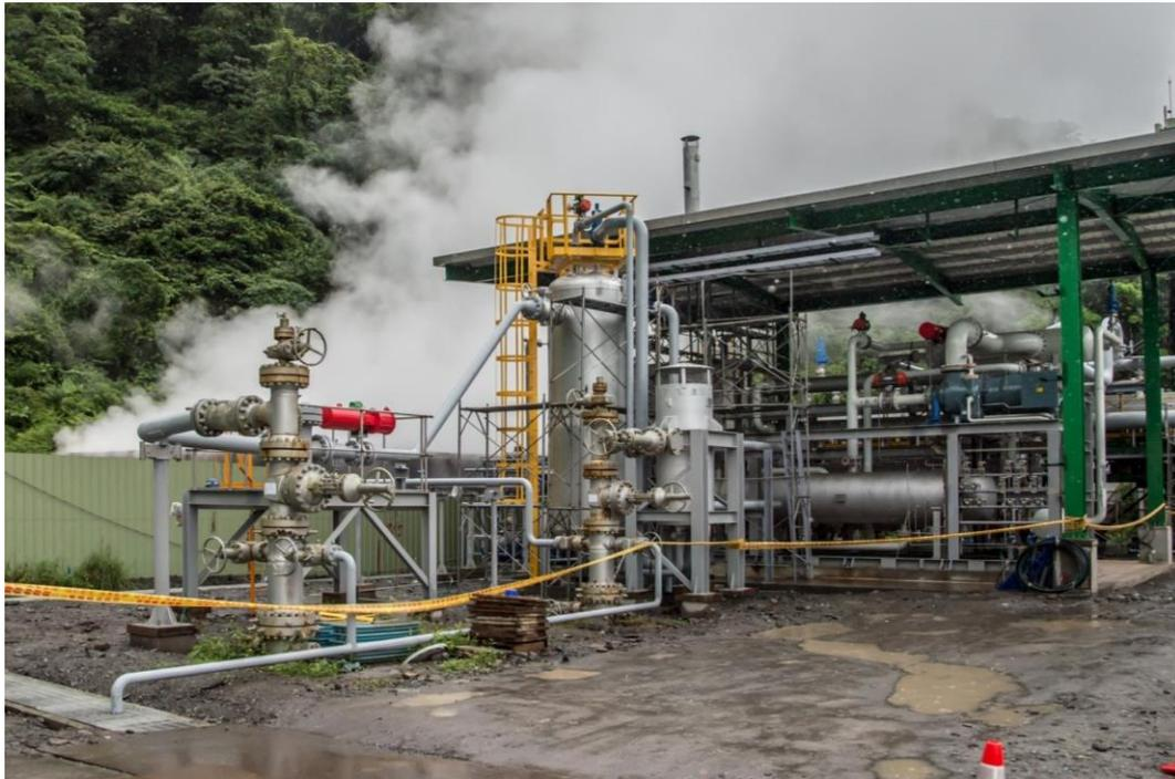
圖 2-3 仁澤地熱電廠朗肯雙循環發電機組
