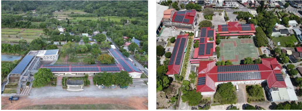
圖 6、縣屬學校屋頂型太陽光電設置情形
