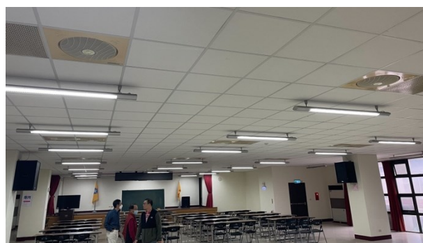
圖 5_竹北市隘口里耗能設備汰換勘查
