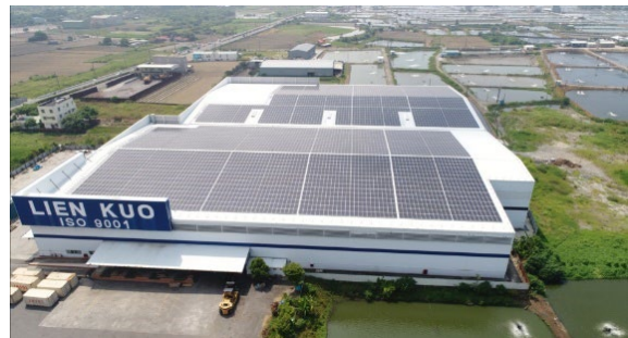
圖 7、綠色廠房設置光電系統
