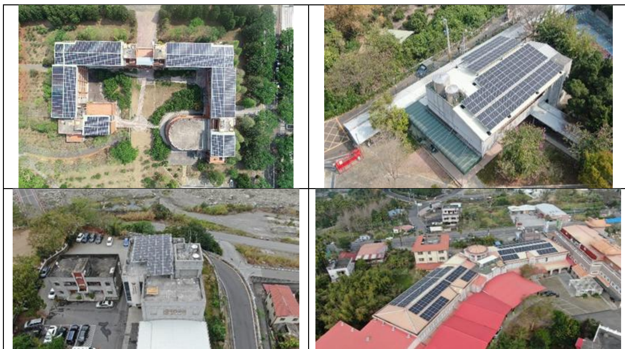
圖10、太陽能光電屋頂案場
