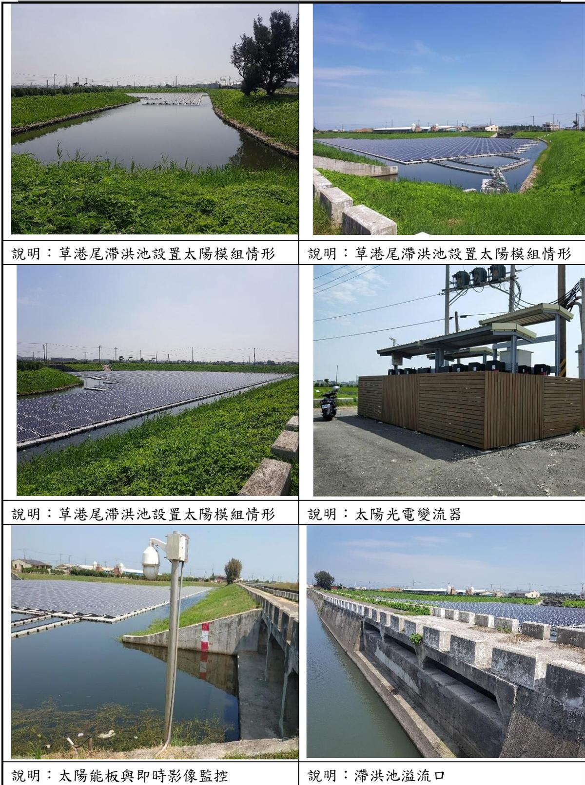
圖2-9 草港尾滯洪池太陽能光電設置情形
