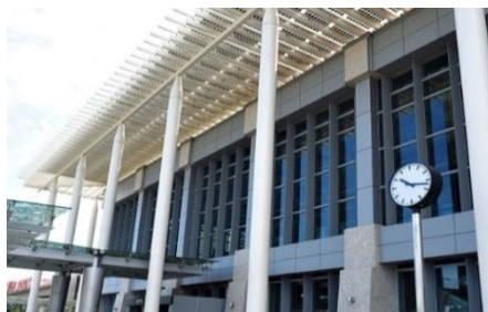
圖 1.10-8 綠建築高鐵苗栗站
