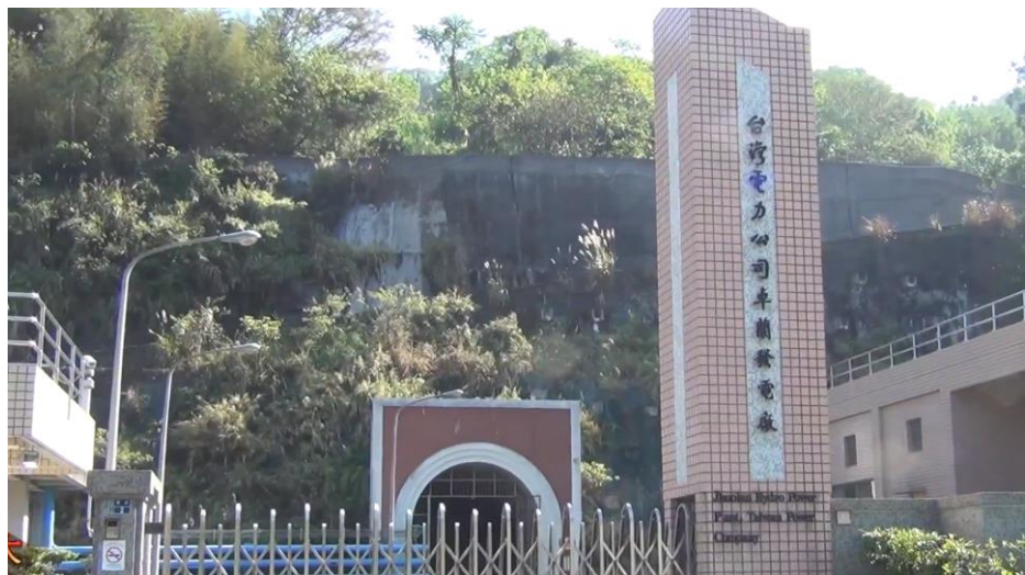
圖 1.10-2 苗栗卓蘭水力發電廠
