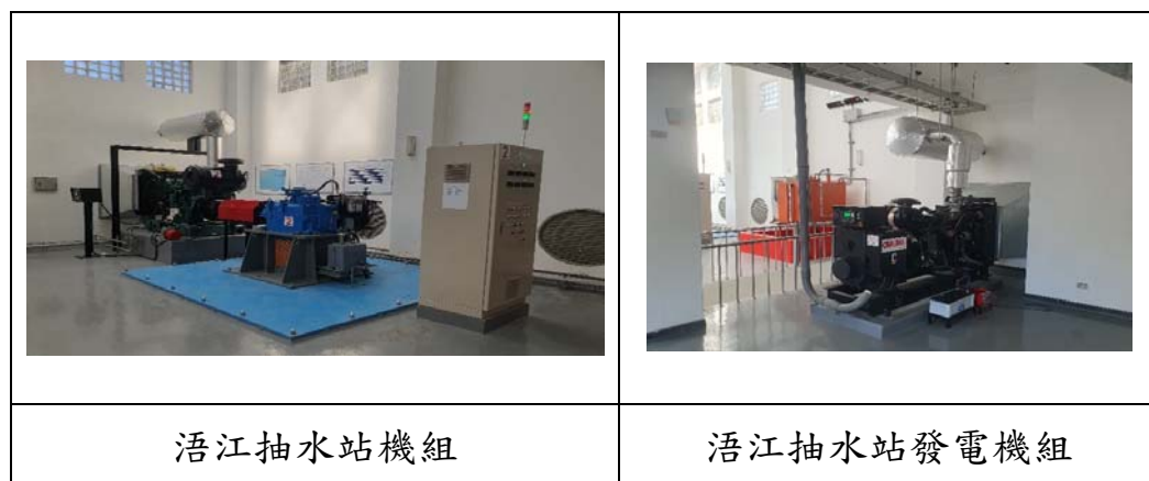
圖 8、浯江抽水站設備設備提昇及改善工程
