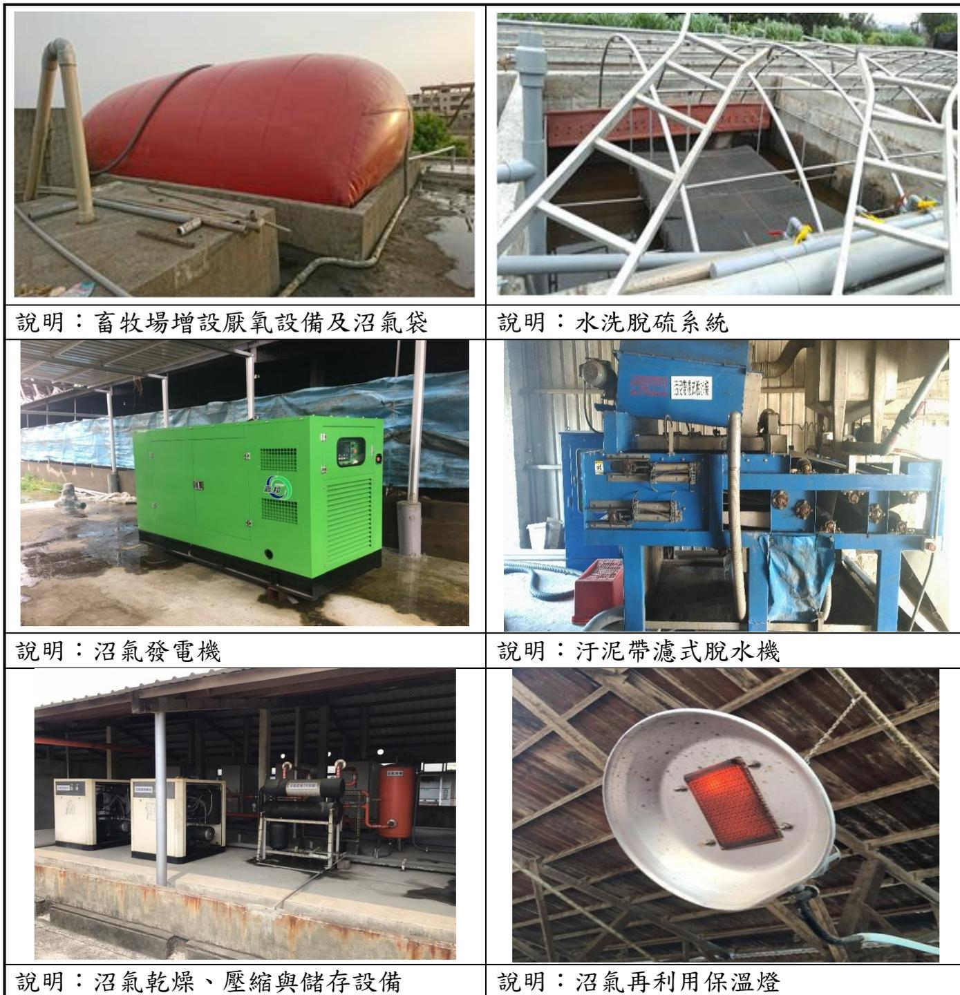
圖 3.1-4 養豬產業發電設備設置情形
