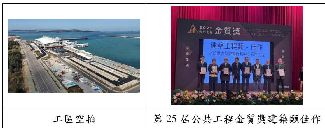
圖 6、水頭港大型旅客服務中心新建工程
