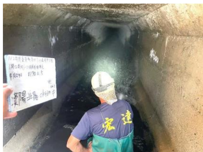
圖2-5 辦理雨水下水道清淤作業
