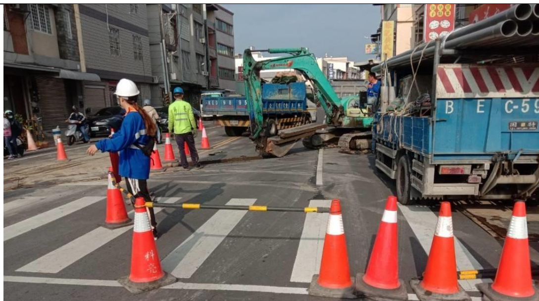
弱電共同管溝建置，整合線路減少道路重複開挖
