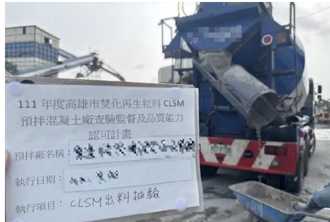
圖 22 焚化再生粒料作為 CLSM 之工程骨材
