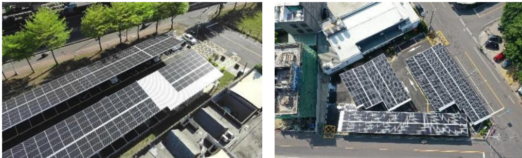
圖 10 公有停車場設置光電系統
