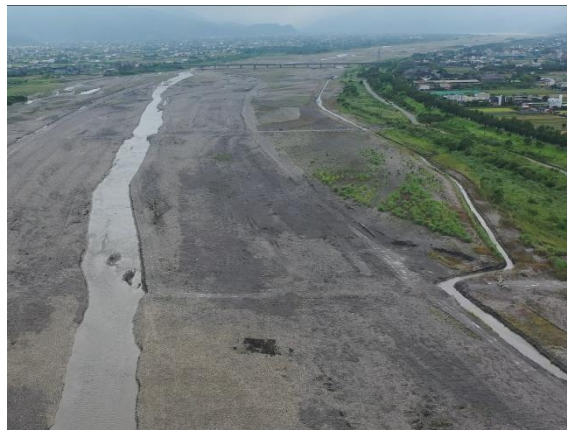
圖2-1 蘭陽溪清除淤積土石
