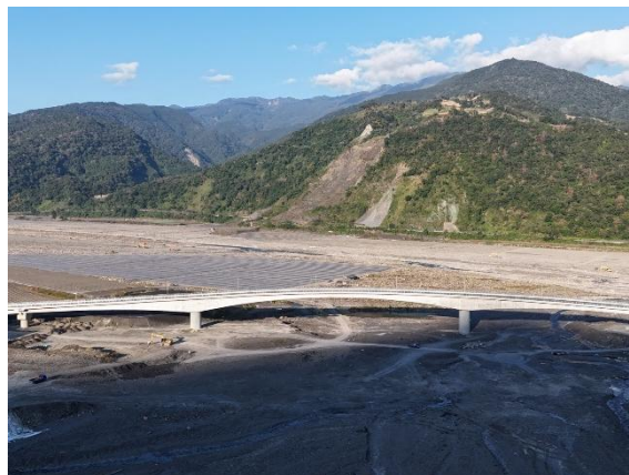
圖2-3 瑪崙橋改建完工照
