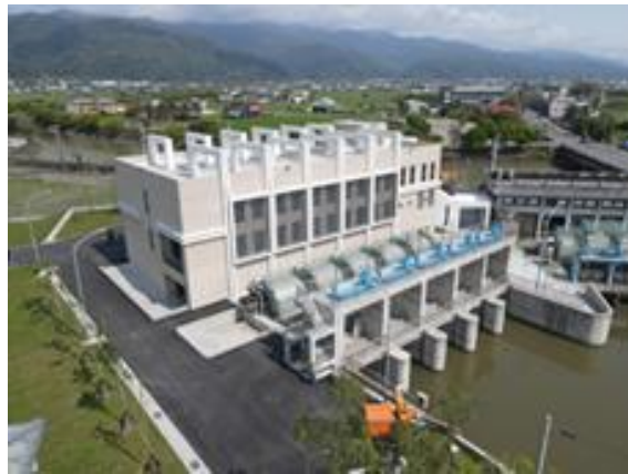
圖2-2 砂仔港2號抽水站完工照
