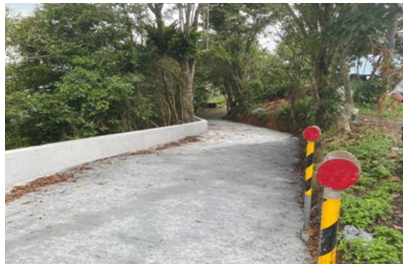
圖2-6 大同鄉崙埤村長崙聯絡道路改善工程
