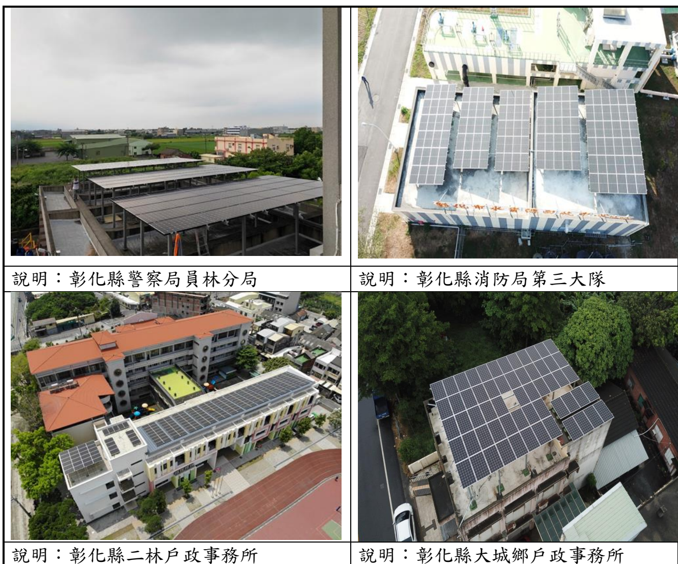
圖 3.1-1 本縣暨所屬機關屋頂設置太陽光電發電系統設置情形
