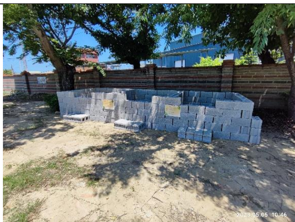
說明：協助設置落葉堆肥設施 (鹿港鎮鹿鳴國中)
