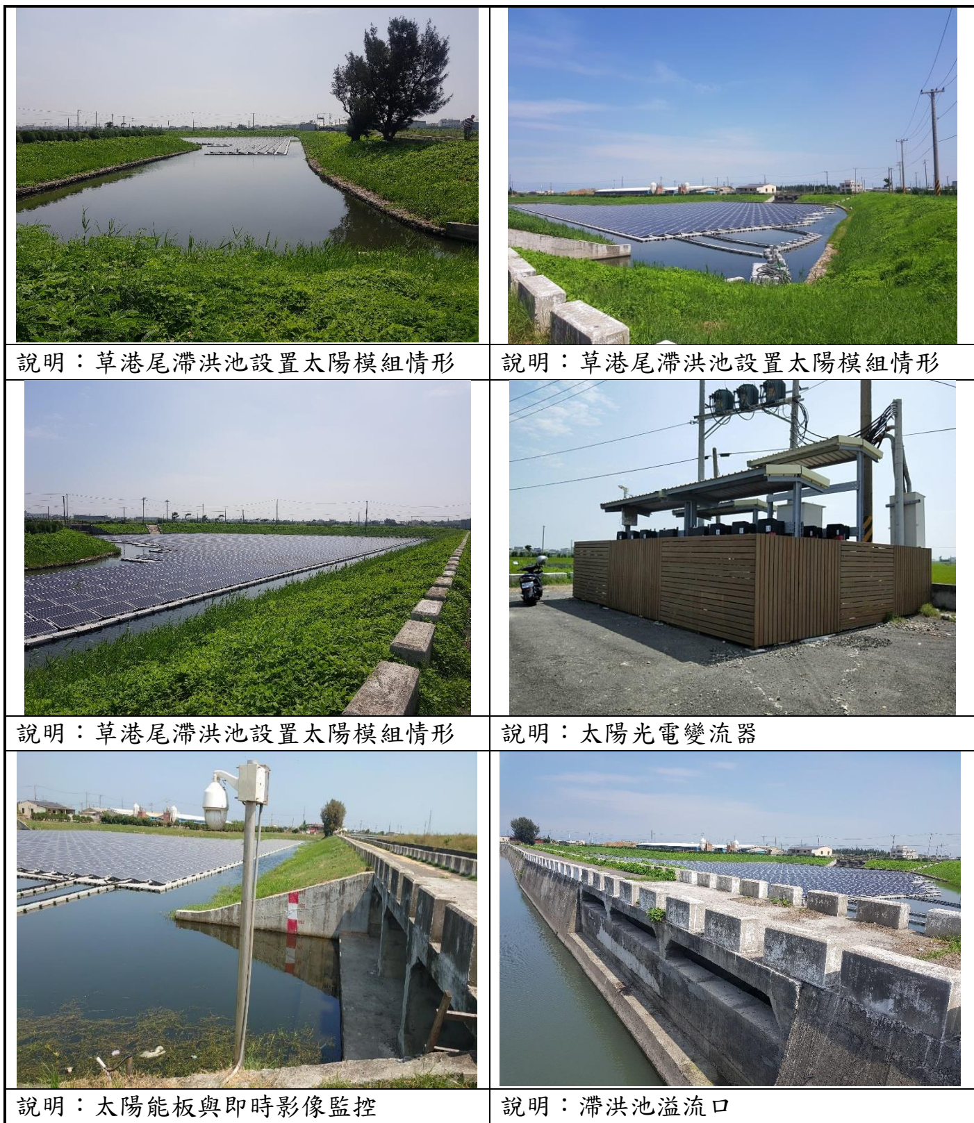
圖 3.1-5 草港尾滯洪池太陽能光電設置情形
