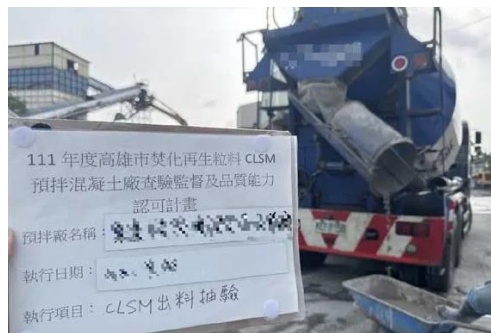
圖 18 焚化再生粒料作為 CLSM 之工程骨
