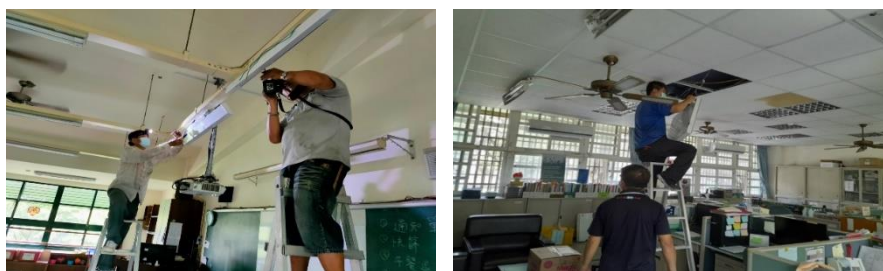
圖 12 汰換老舊設備
