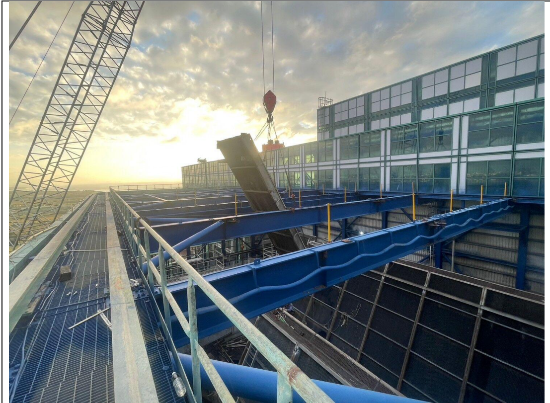
圖8_焚化廠升級整備工程
