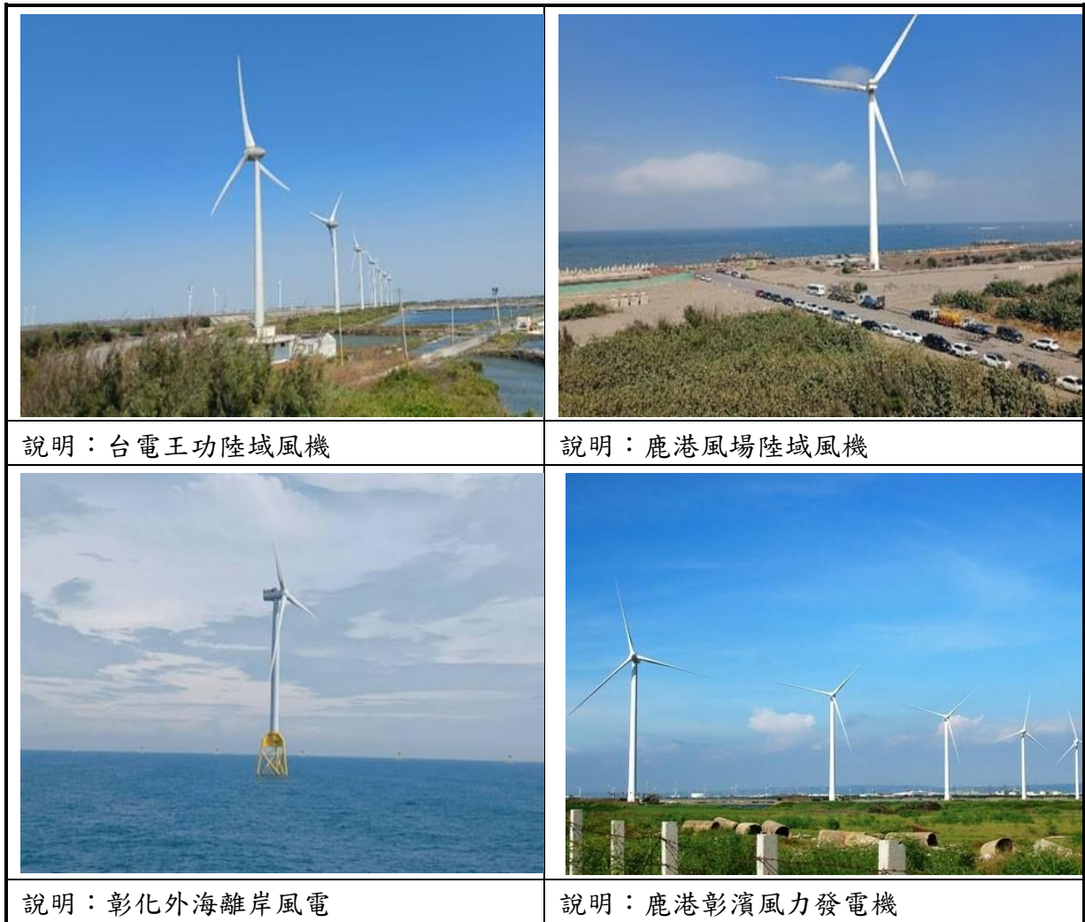
圖2-7 風力發電設置情形
