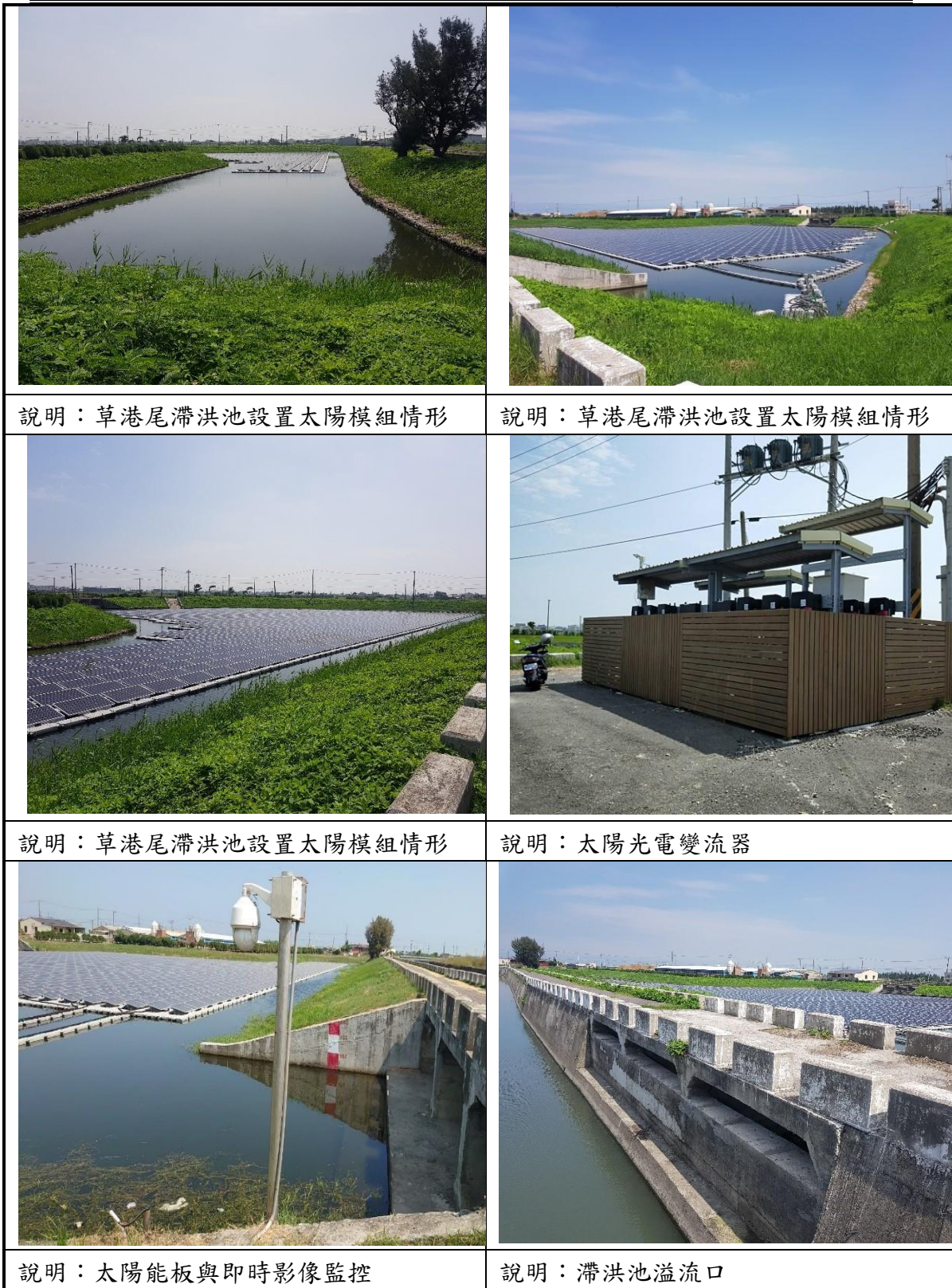
圖2-9 草港尾滯洪池太陽能光電設置情形
