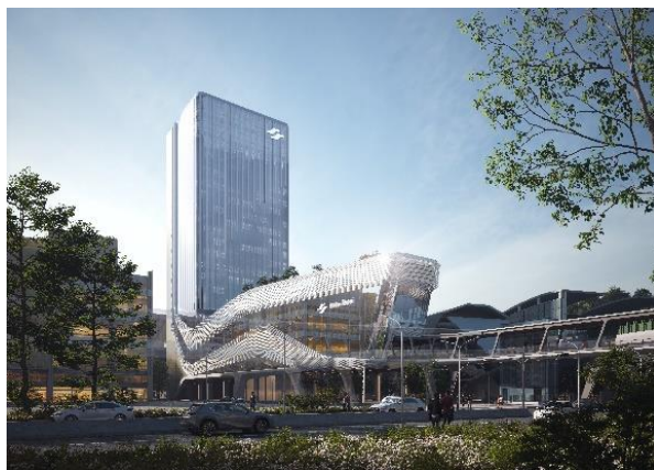
捷運劍南路站多目標大樓
