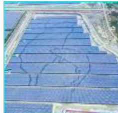
PV電廠(台南)
