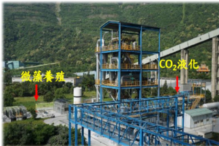
台泥鈣迴路碳捕捉先導廠
