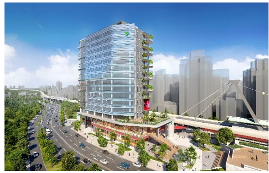
捷運劍潭站多目標大樓
