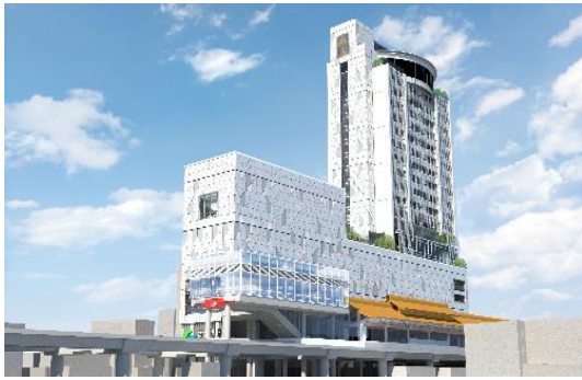
捷運士林站多目標大樓
