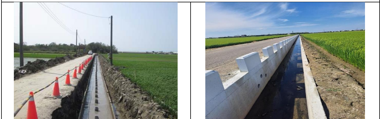
3-2-3 早期農水路更新改善：滲水孔施作情形、生態孔完成
