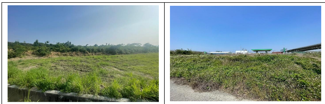
圖 16 裸露地綠化之辦理情形
