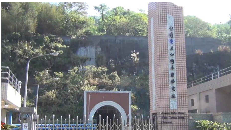
圖 1.10-2 苗栗卓蘭水力發電廠
