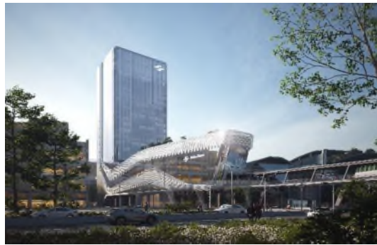
捷運劍南路站多目標大樓
