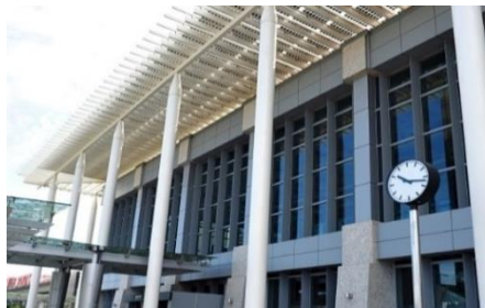
圖 1.10-8 綠建築高鐵苗栗站
