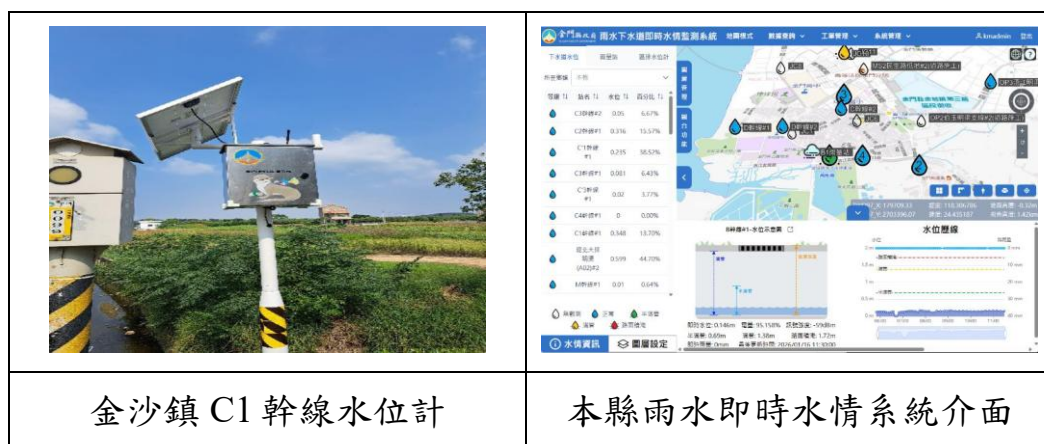
圖 12、金門縣雨水下水道即時水情監測系統建置計畫
