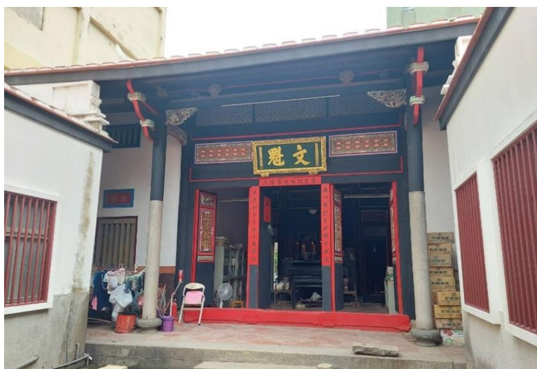
圖2.15 臺南石鼎美古宅門廳修復工程
