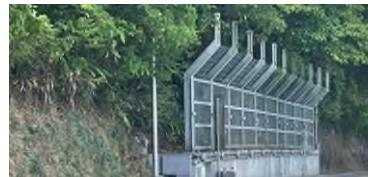
台9線117K落石告警系統
