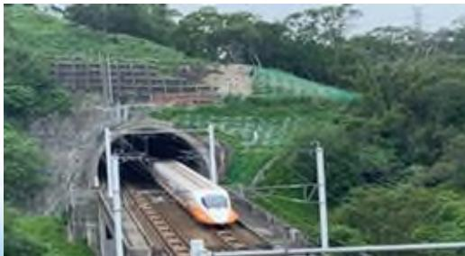
強化沿線隧道洞口及高陡植生邊坡之防護工程 - 寶山一甲隧道北洞口照片
