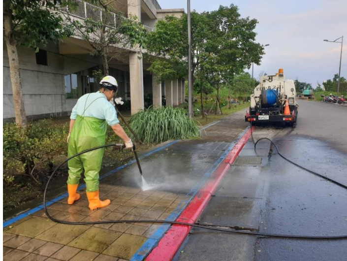
圖 2-11 運用回收生活污水清洗地面
