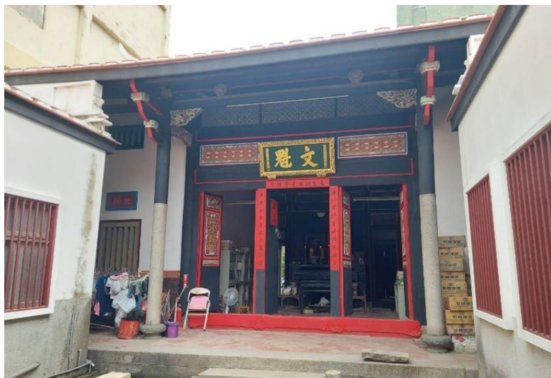
圖2.15 臺南石鼎美古宅門廳修復工程
