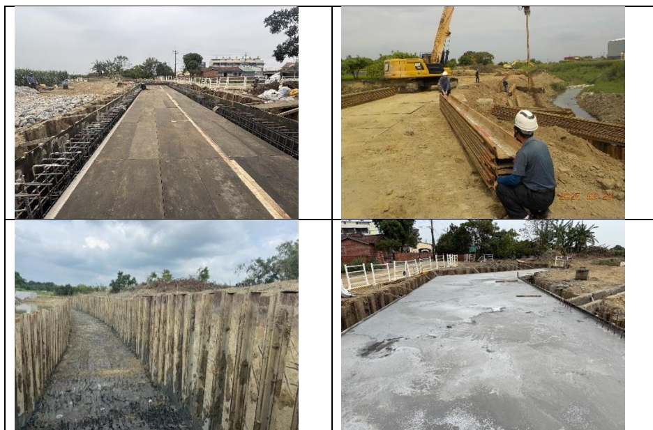
圖2.1 縣市管河川及區域排水整體改善計畫114年度應急工程
