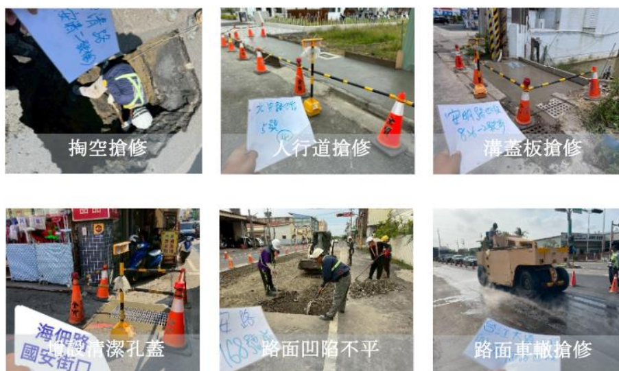
圖2.3 已辦理之橋梁改建及道路搶修工程
