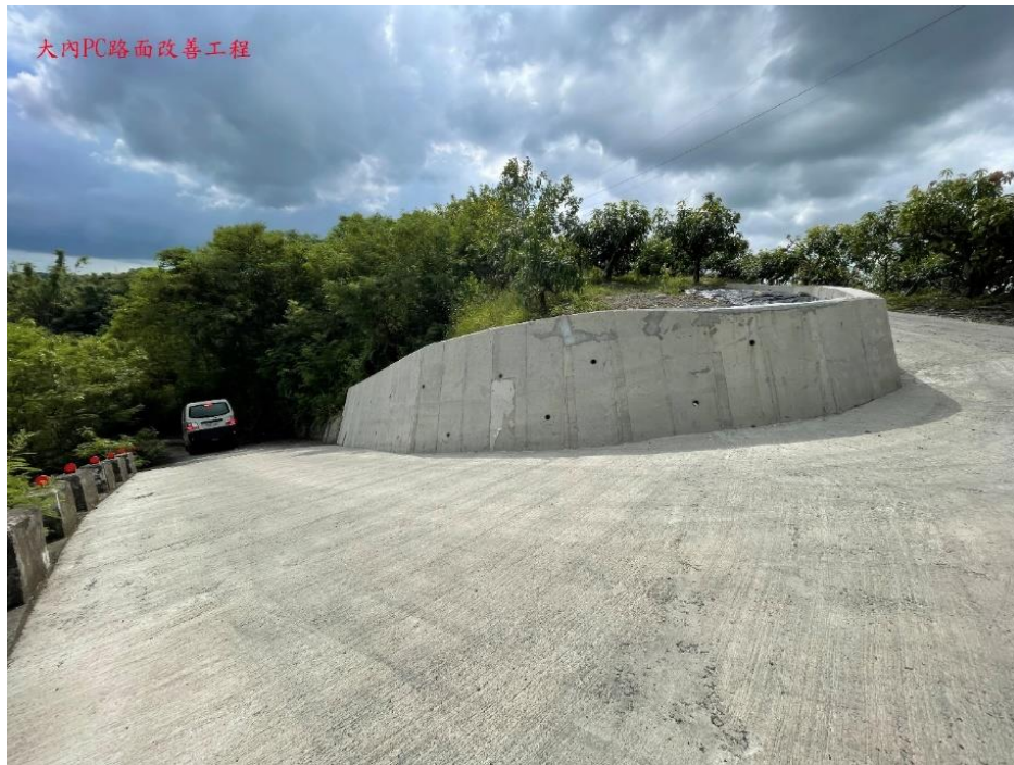
圖2.4 市內非重劃區既有農水路改善
